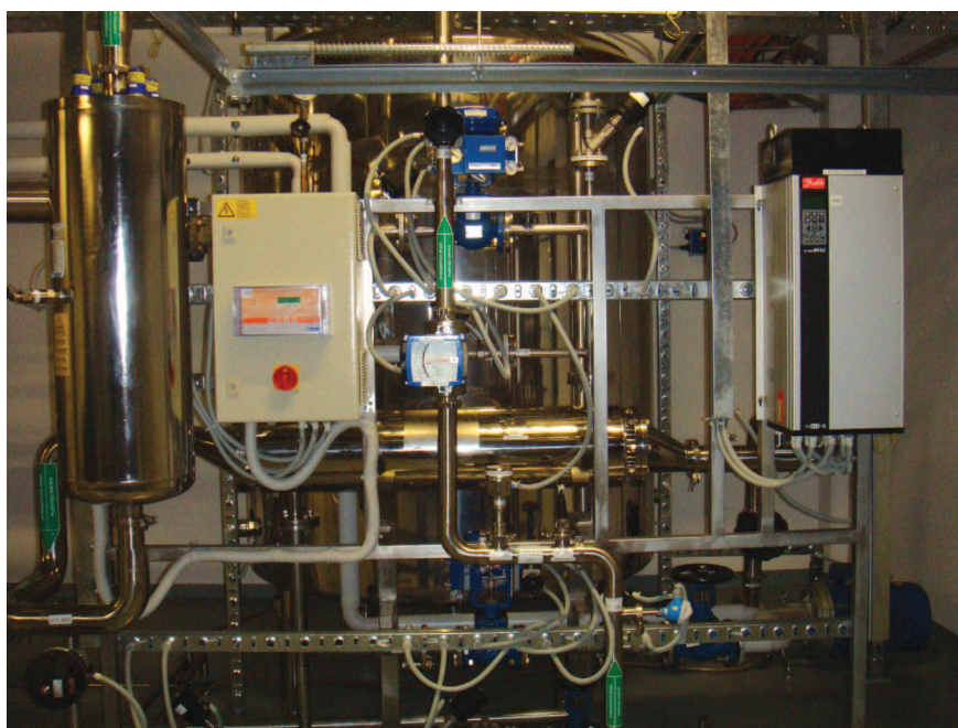
Рис. 11. Система распределения воды очищенной с периодической температурной санацией. ООО Сердикс, Московская обл.
