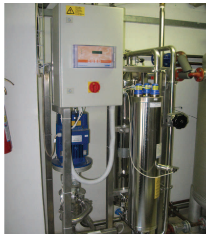
Рис. 10. УФ-стерилизатор BEWADES 390 P, ЗАО «ГЕДЕОН РИХТЕР-РУС»
